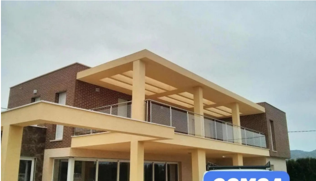
Taller santazos carpintería metálica de aluminio hierro y cerrajería pvc y cristalería del propietario
