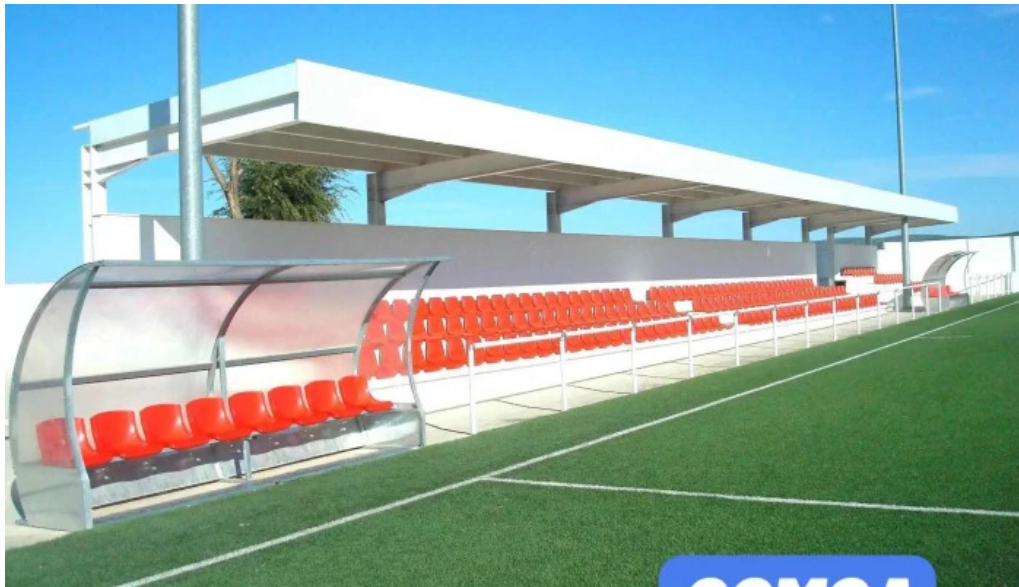
Cerrajería isver s l interior
