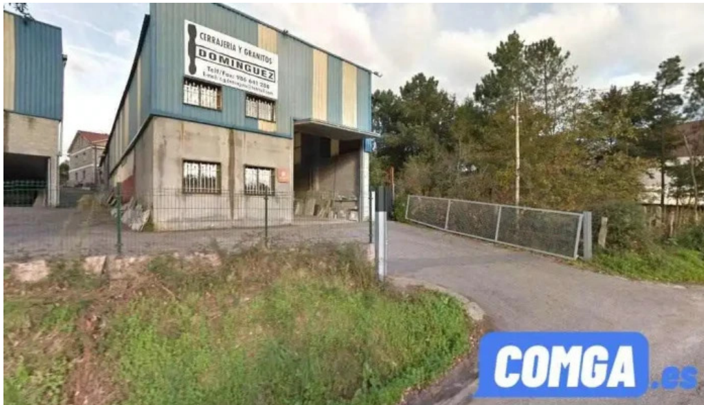
Cerrajería granitos dominguez a gandara
