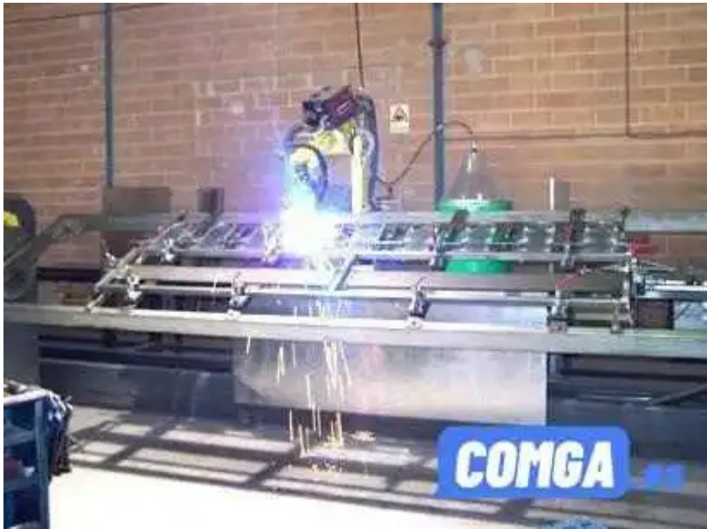
Cerrajería culebras interior
