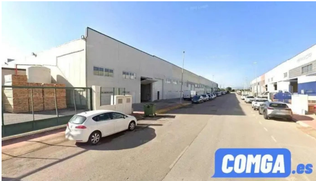
Cerrajería chimeneas metálicas almassora
