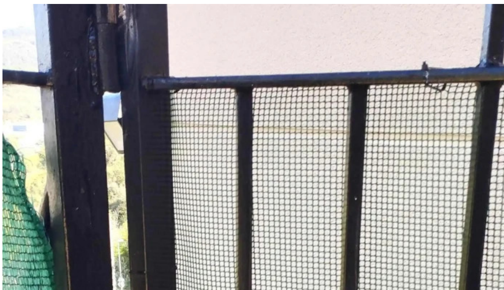
Cerrajería badosa sl argentona
