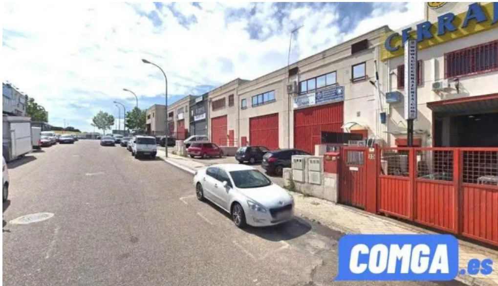
Acu cerrajería s l arroyomolinos
