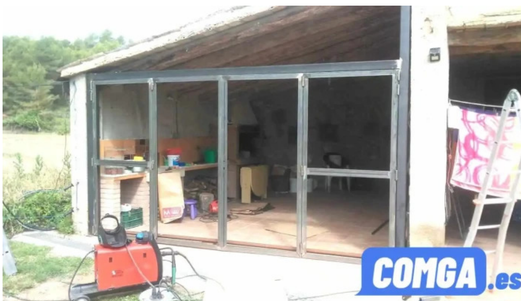
Cerrajería mantenimiento d jorba barcelona
