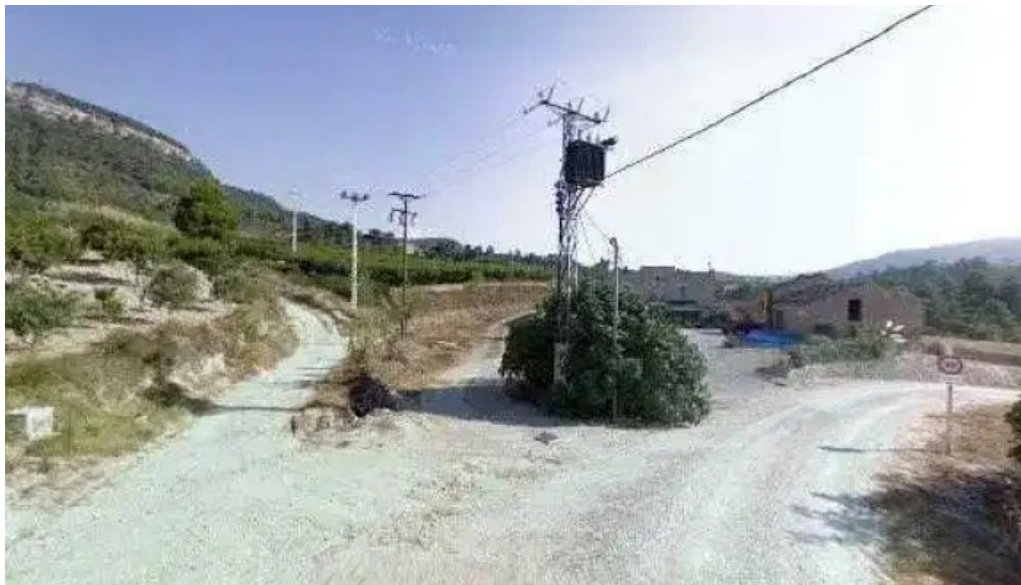
Cerrajería mantenimiento d jorba direccion
