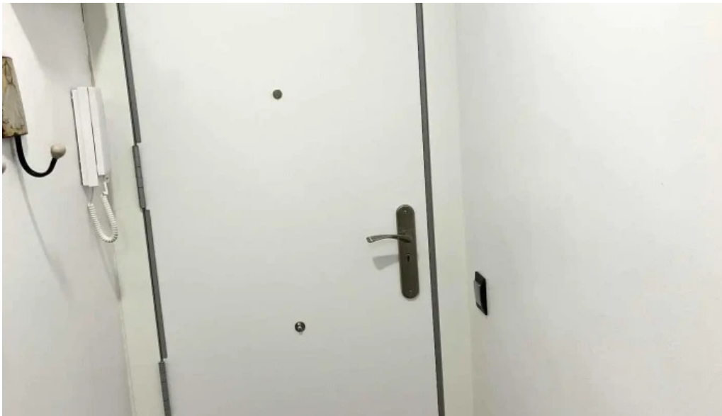
Rejas y puertas blindadas ambtottancat interior
