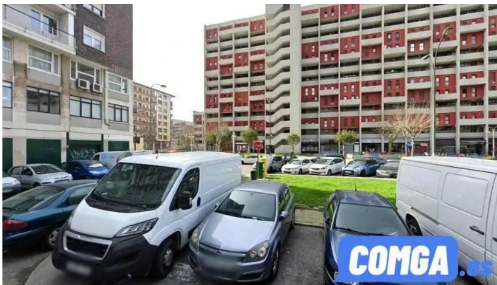
Reparaciones san ignacio bilbao
