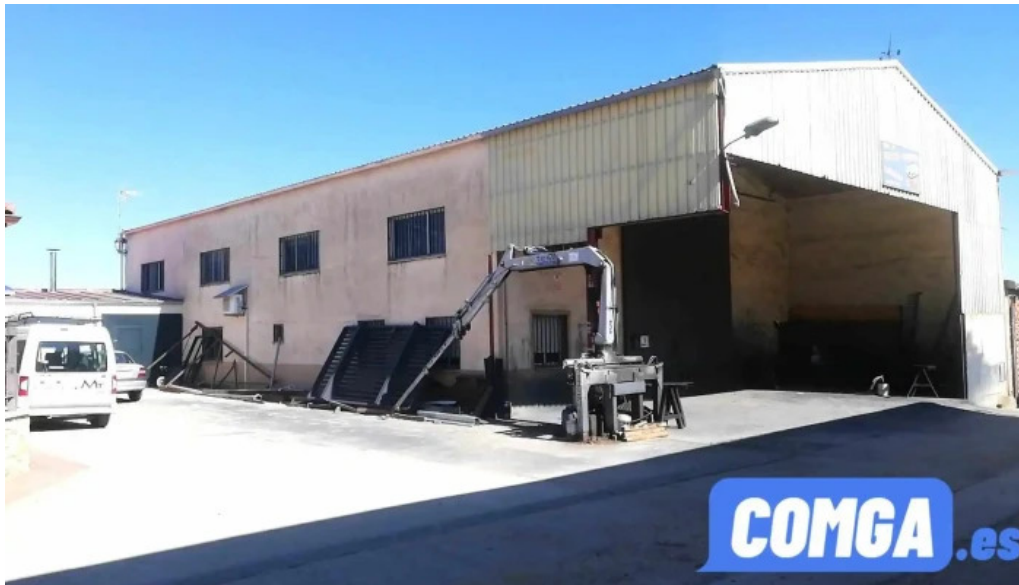
Cerrajería estructuras metálicas m t cantalpino
