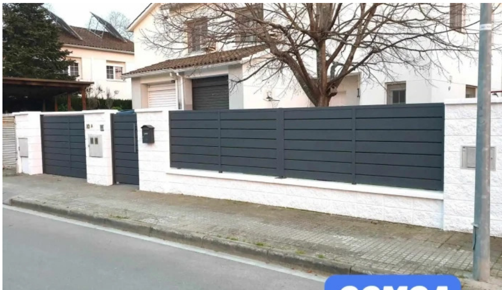
Cerrajería jate scp exterior
