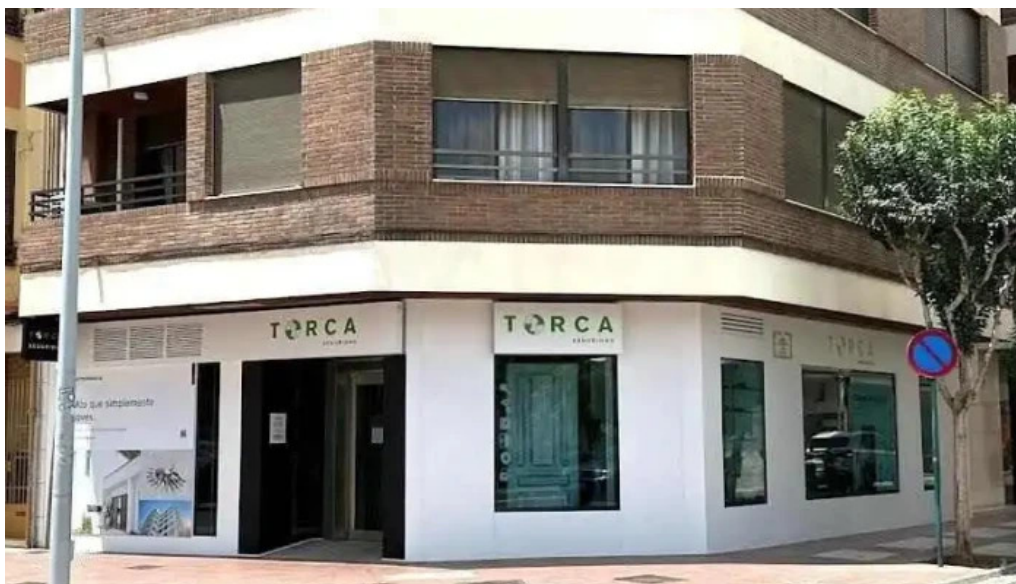
Torca tecnico cerrajero en seguridad castellon de la plana
