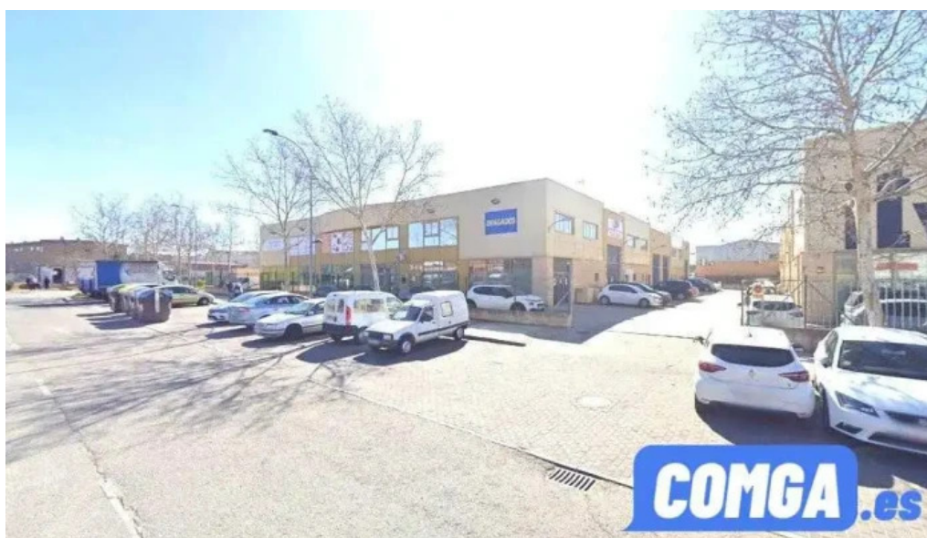
Cerrajería fernando collado villalba
