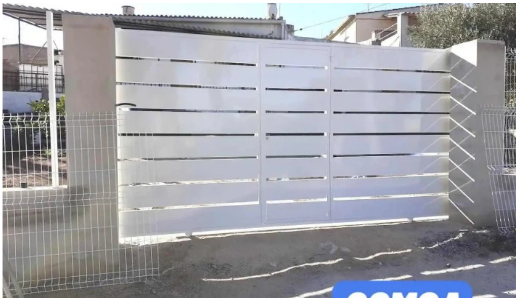
Cercados y cerrajería j nicolas estacion de blanca
