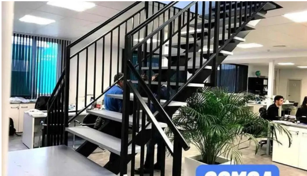
Cerrajería steel interior
