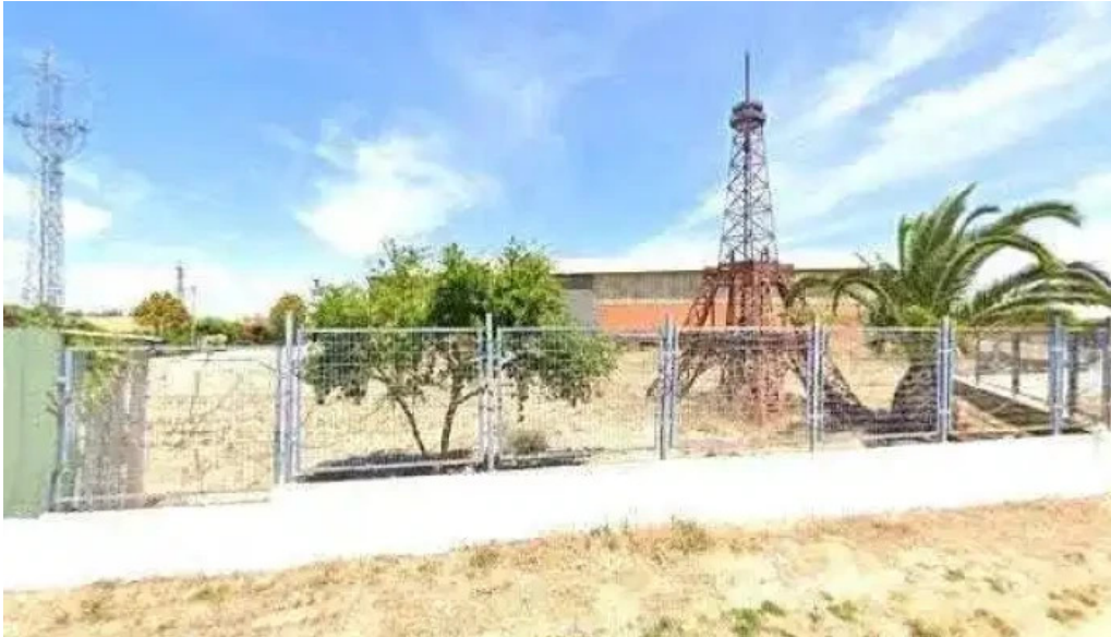
Talleres y montajes metálicos si opiniones
