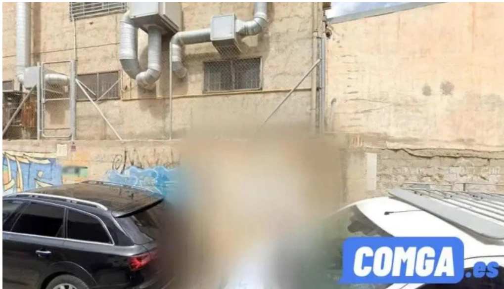
Estructuras metalicas dinamo huerca de almeria
