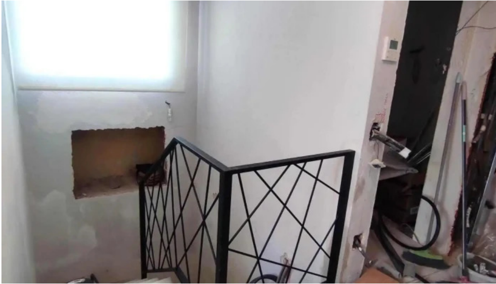
Cerrajería sierra norte interior
