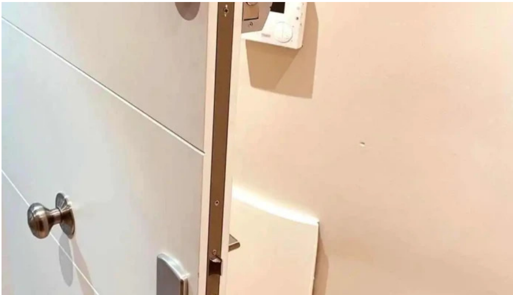
Doorlock instalación de cerrojos de seguridad interior
