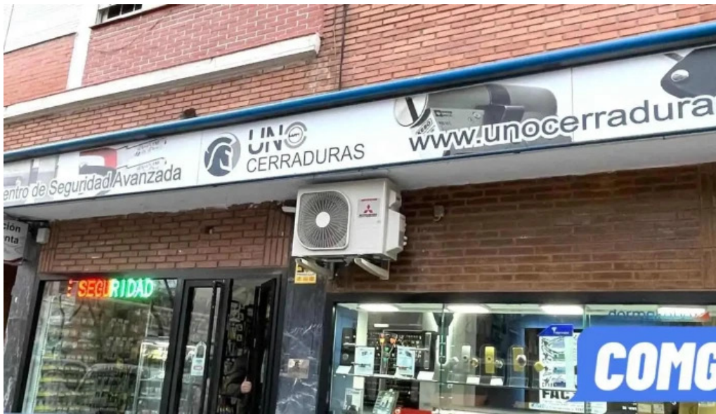
Uno cerraduras exterior
