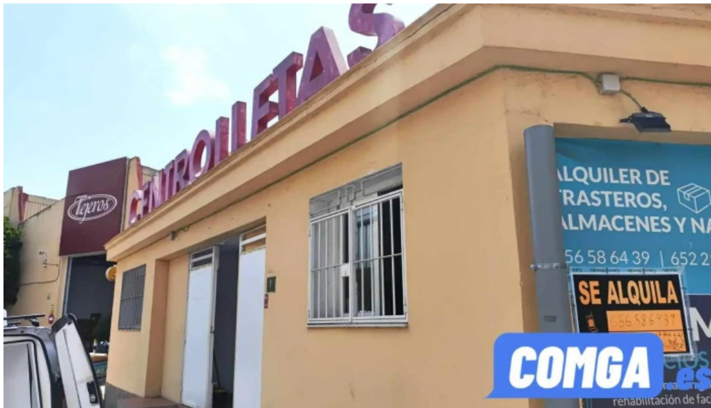
Cerrajería olletas exterior
