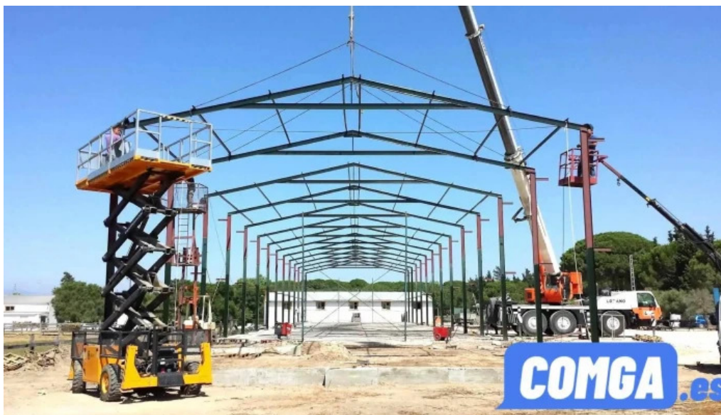
Cerrajería frasan malcocinado
