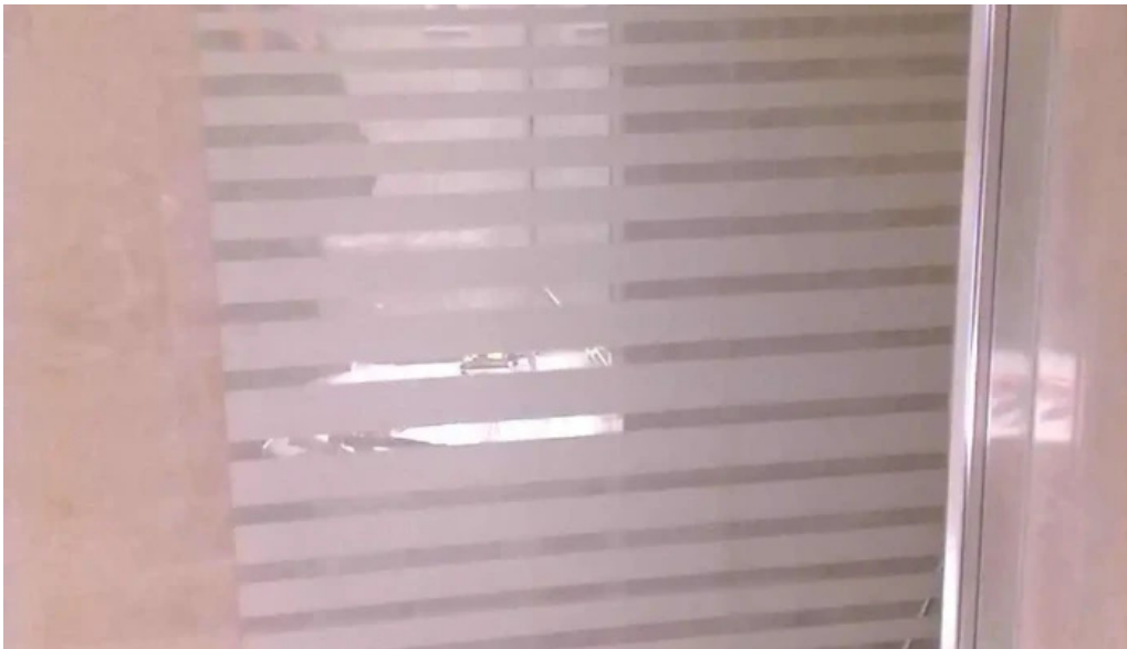
Guadamental cerrajerías interior
