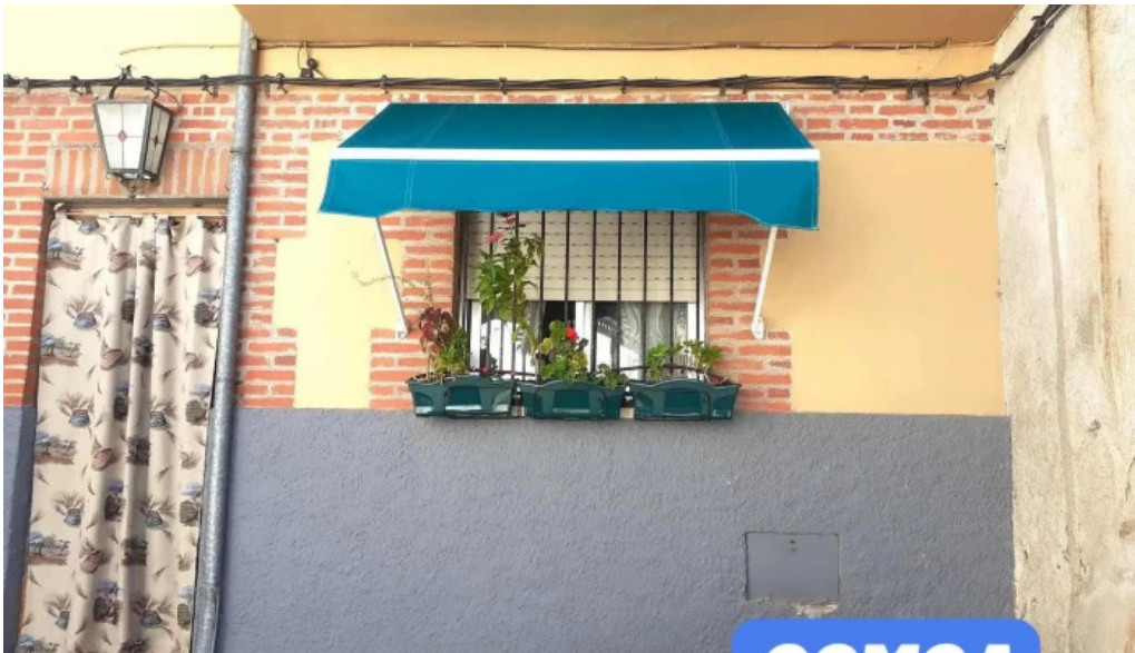
Cerrajería zapardiel exterior
