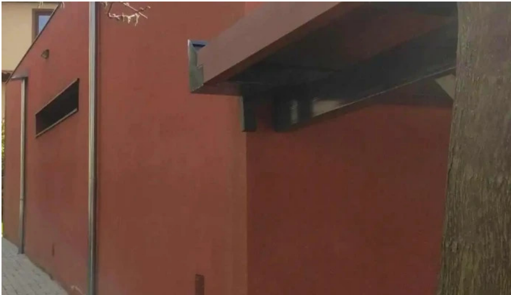
Cerrajería y construcciones metálicas hnos sanz sl vídeos
