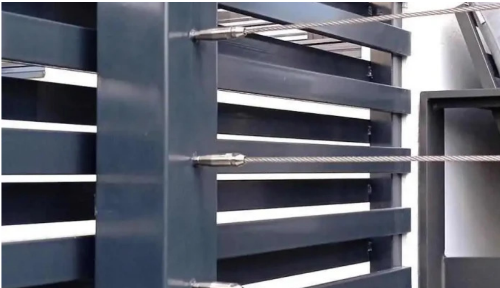
Cerrajería metalpim interior
