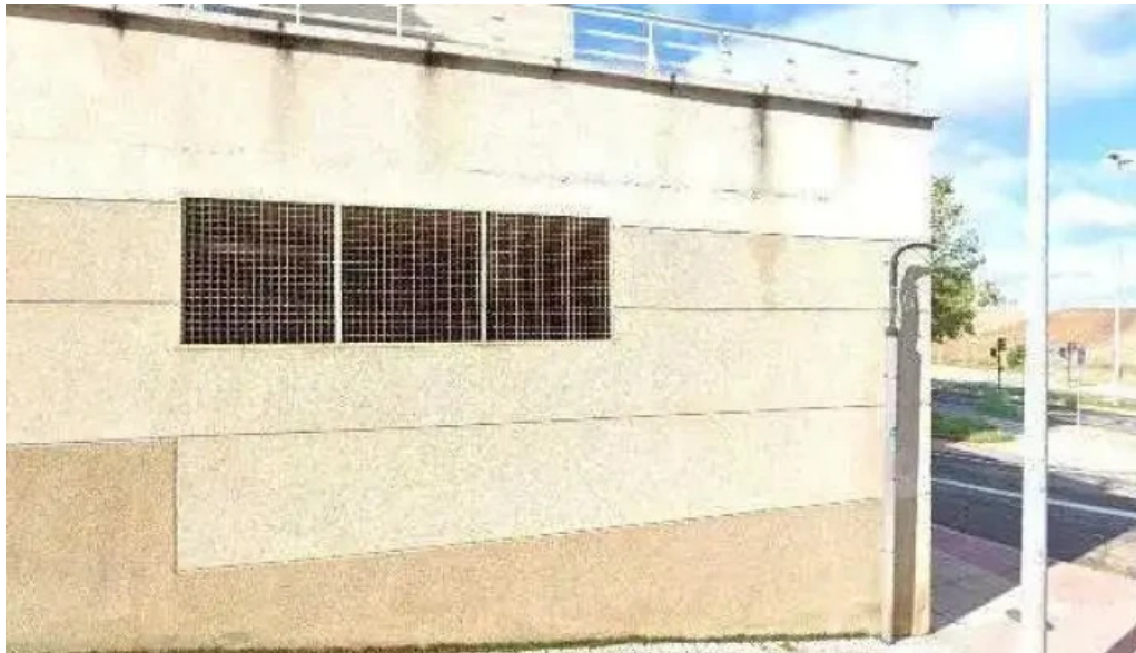
Cerrajería luengo donde
