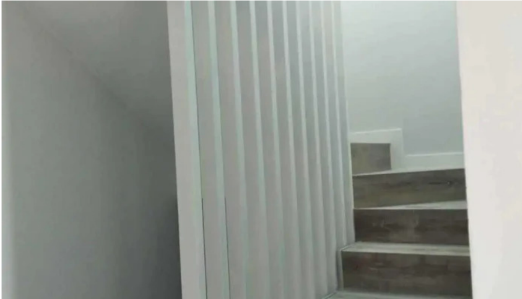
Cerrajería y construcciones monrosa interior
