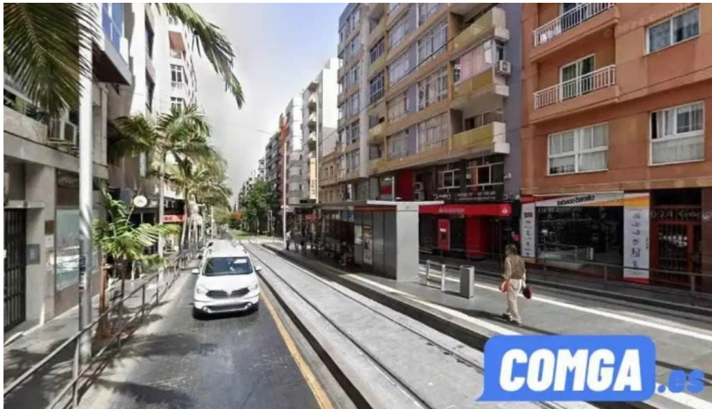
Reparaciones inmediatas t canarias santa cruz de tenerife
