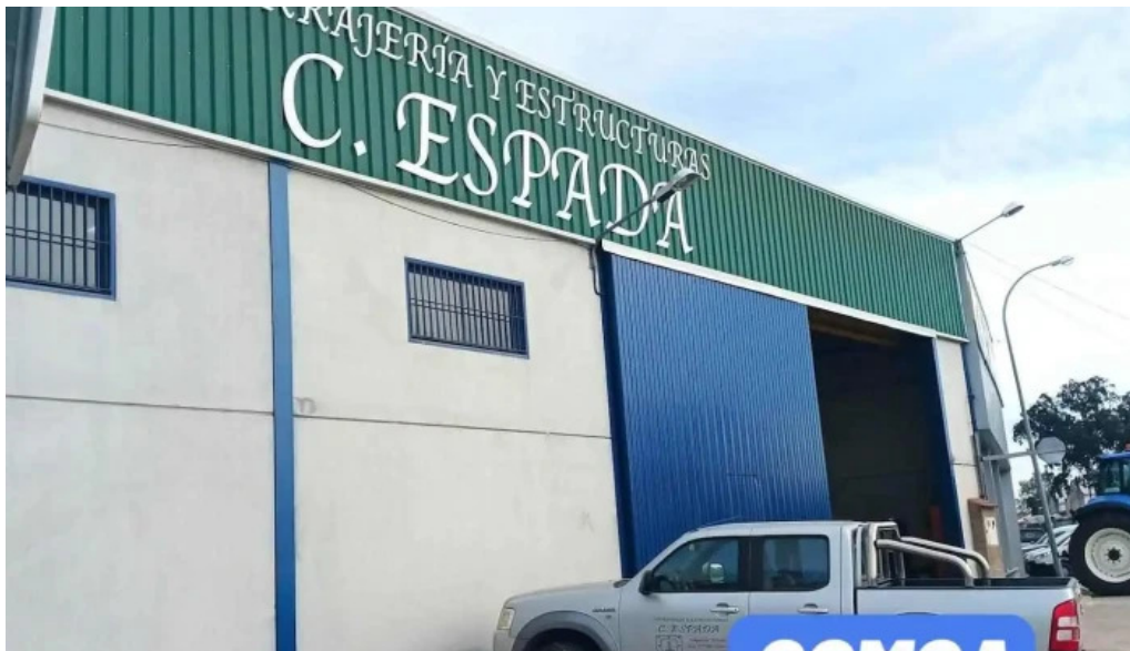
Cerrajería y estructuras c espada tietar
