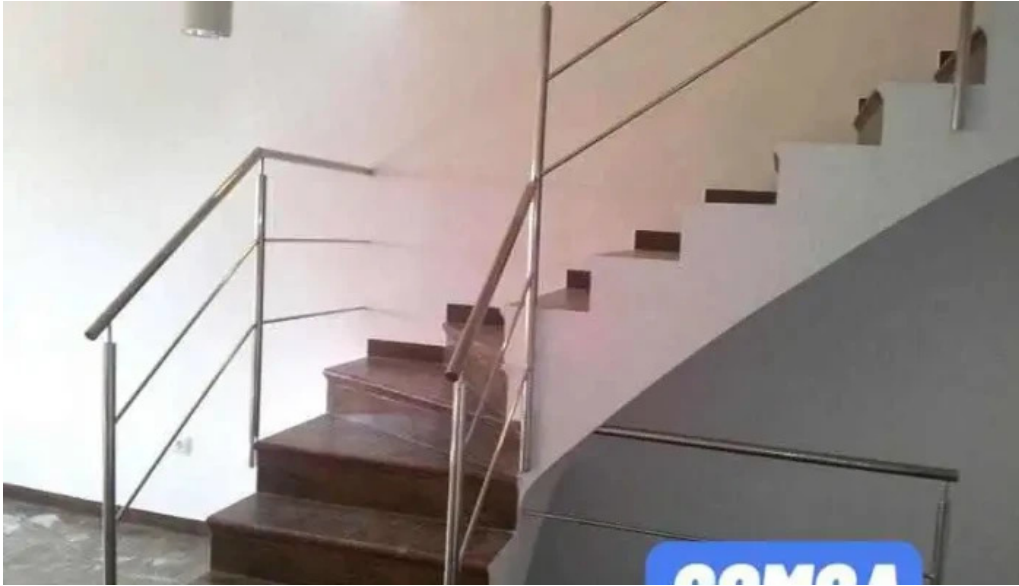
La ferreria interior
