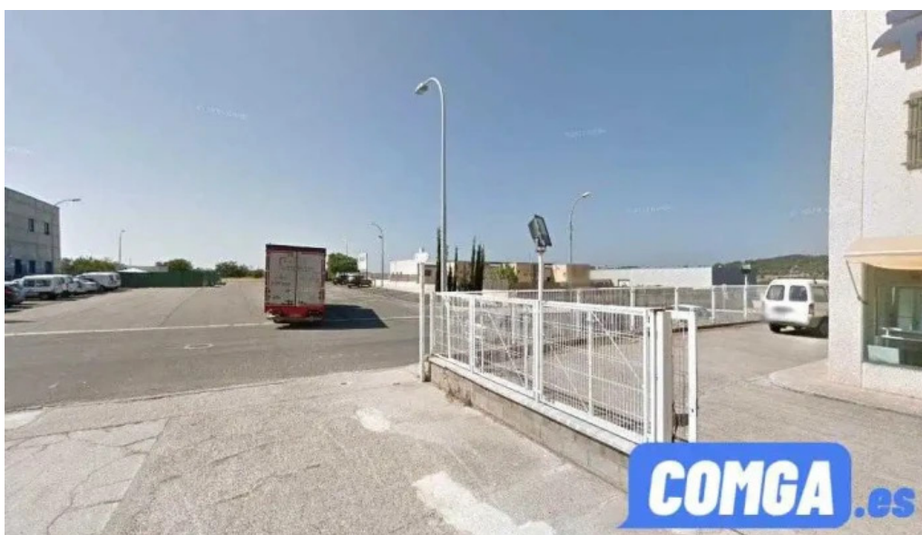
Serralleria f nuevo torredembarra
