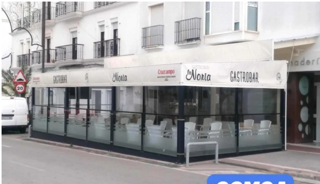
Estructuras cerrajería varmu sl del propietario
