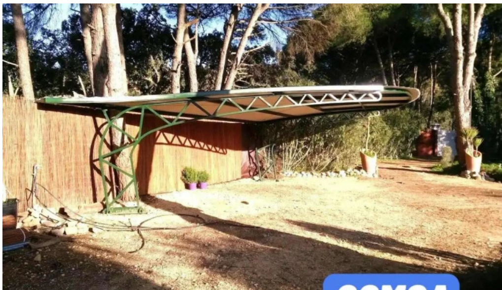
Estructuras cerrajería varmu sl vejer de la frontera
