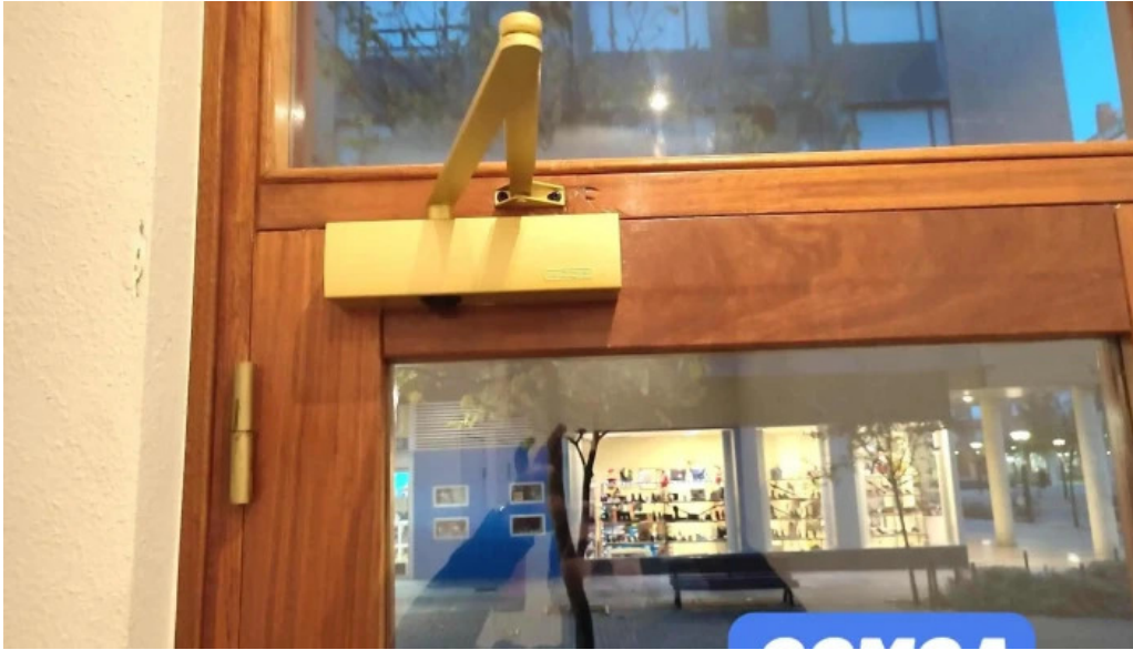
Cerrajería patxi exterior
